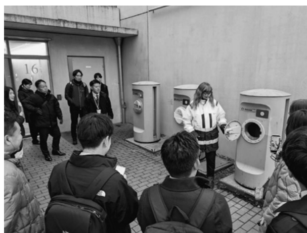
自動真空式ごみ収集システム
