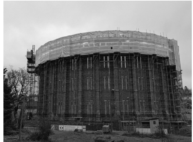
旧ガス工場のリノベーション工事
