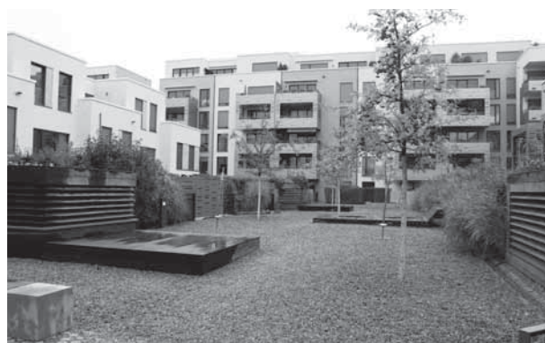
地下駐車場上部の緑化
