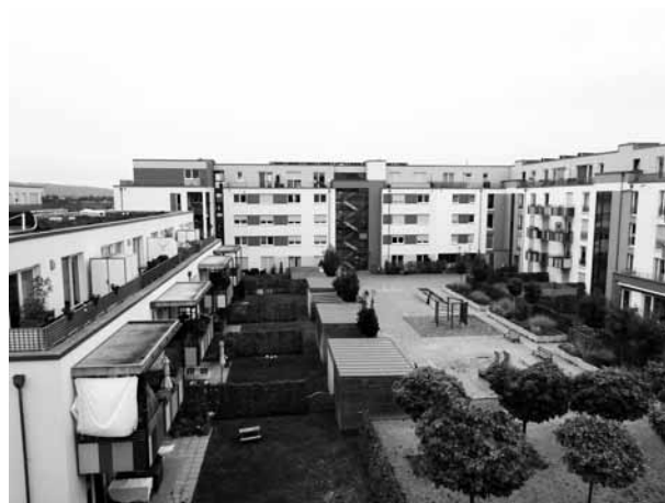
高齢者センターから望む庭と一体的な建物の風景
