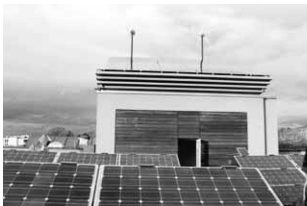
屋上に設置された太陽光発電システム
